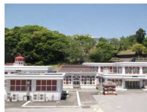
新浄水施設完成
