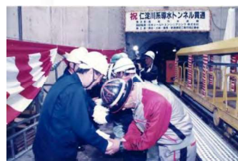
仁淀川系導水トンネル貫通
