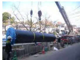
(1工区)管の吊り下ろし
