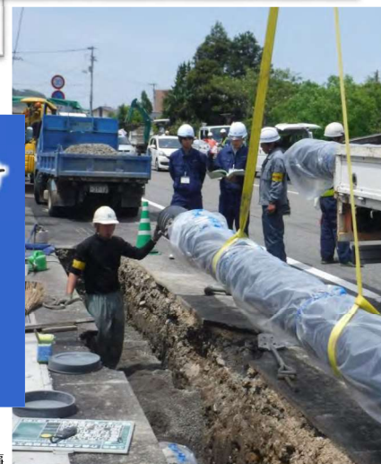
▶基幹管路(配水本管)の耐震化工事
