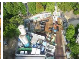
(5工区)到達立坑全景
