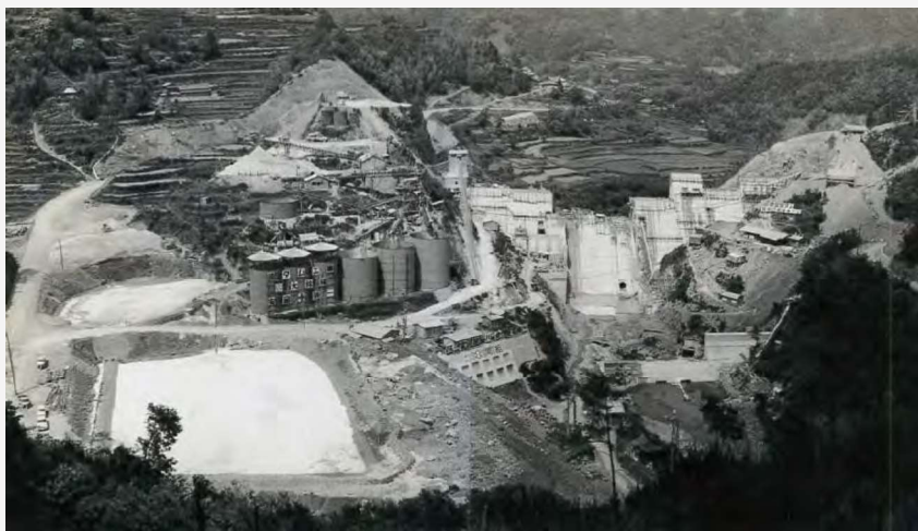
鏡ダム建設工事
