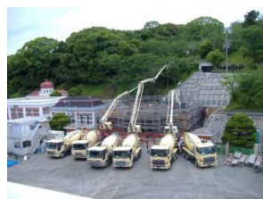
管理棟コンクリート打設
