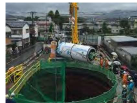
(3工区)シールドマシン吊り下ろし
