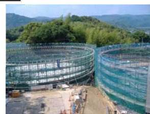
配水池配筋状況
