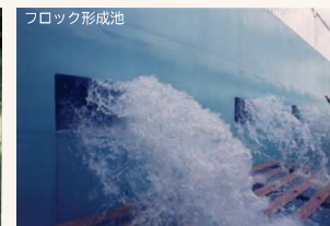
総合試運転(平成9年2月)
