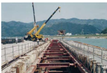
集水管埋設工事
