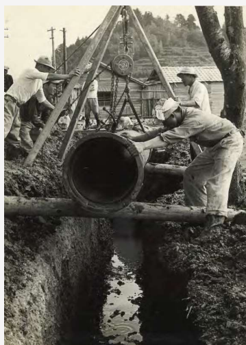
配水管布設(福井町)
