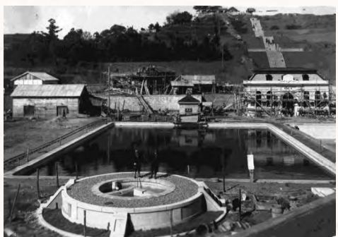
上 御殿山に浄水場建設を着手(大正13年3月) 中 配水池鉄筋組立及び地底コンクリート工事(大正13年6月) 下 建設進む浄水場(大正13年12月)
