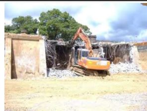
旧1号配水池取壊し
