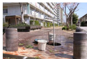
応急給水栓 (市内60か所に設置)
