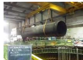
(3工区)ダクトイル鉄管搬入状況
