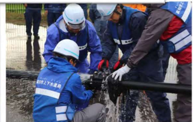
応急復旧訓練
