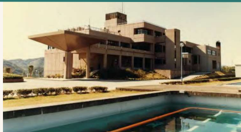
針木浄水場完成(昭和54年3月)
