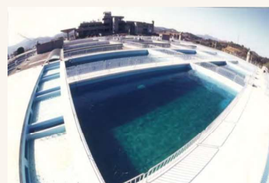
2系浄水施設完成
