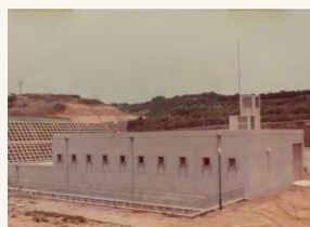
中継ポンプ所
