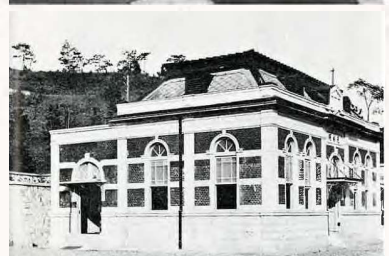
上 集水管埋設工事(鏡川郭中堰上流) 中 取水所(宝橋付近) 下 送水ポンプ室
