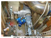
不断水割T字管設置状況
