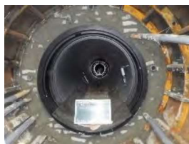
(5工区)二次覆工完了
