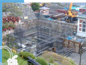
地下浄水池配筋状況
