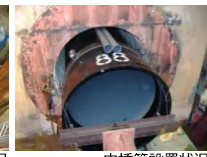
内挿管設置状況
