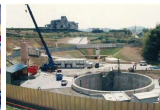
揚水所建設状況
