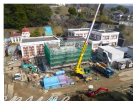
後塩素混和池施工
