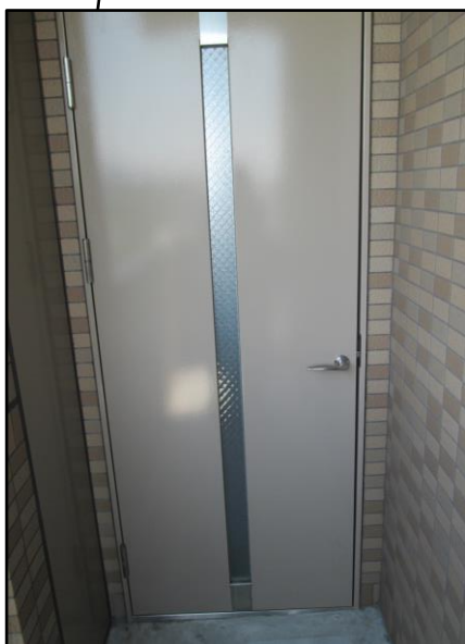
外階段から避難スペースへの入口
