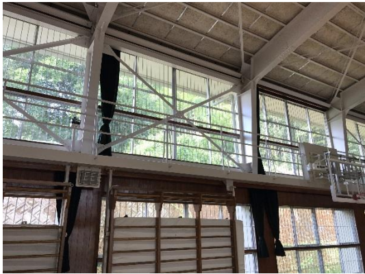
①体育館：ガラスの割れはないか、扉のゆがみがないか確認
