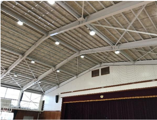
②体育館：照明などの落下物がないか
