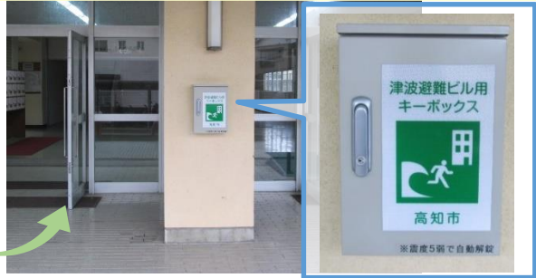
自動解錠装置付キーボックス設置箇所
