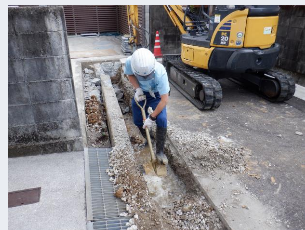
管路管理課 破損した水道管の修繕作業
