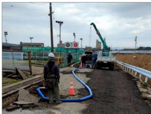
ポンプと仮設排水管による汚水の移送
