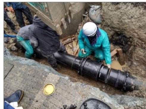
水道管の応急復旧
