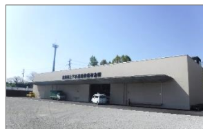
資機材倉庫 （応急給水資材置場）
