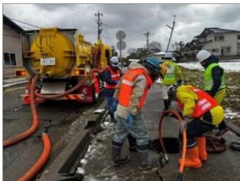
バキュームによる汚水吸引
