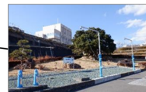
応急給水拠点（給水柱計6柱）
