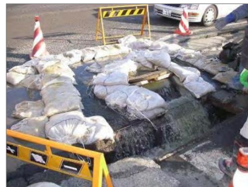
土のうによる仮設水路の設置 (汚水を消毒後、側溝へ放流)
