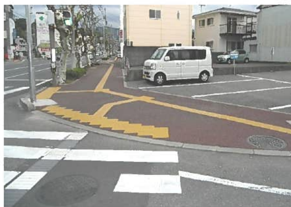
〈歩道の段差解消〉
