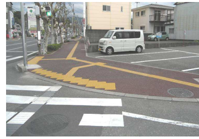
〈歩道の段差解消〉
