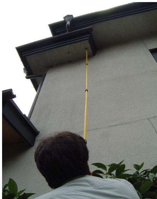
外壁の寸法調査
