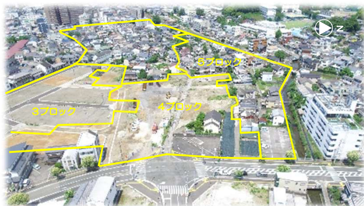
区画整理事業 施行中の状況
