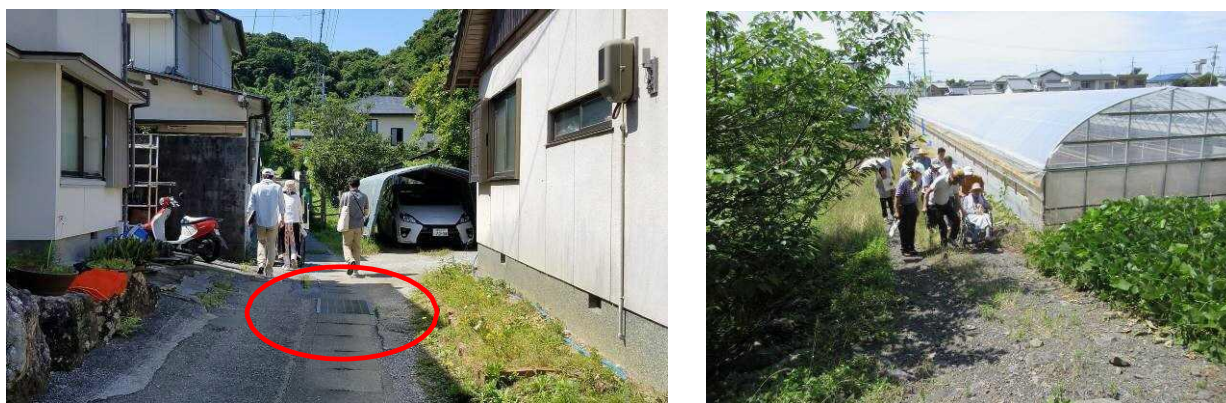
図6-2 避難行動要支援者の避難の妨げとなる箇所
