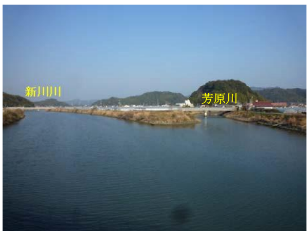
【写真8】新川川中流護岸（西諸木）
