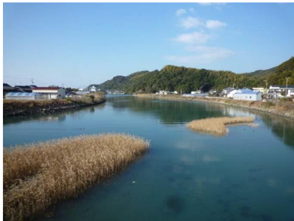
【写真6】甲殿川護岸
