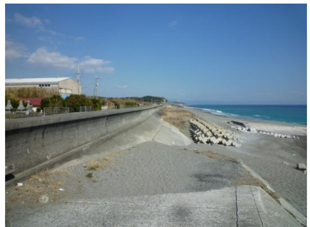
【写真2】 戸原地区海岸堤防
