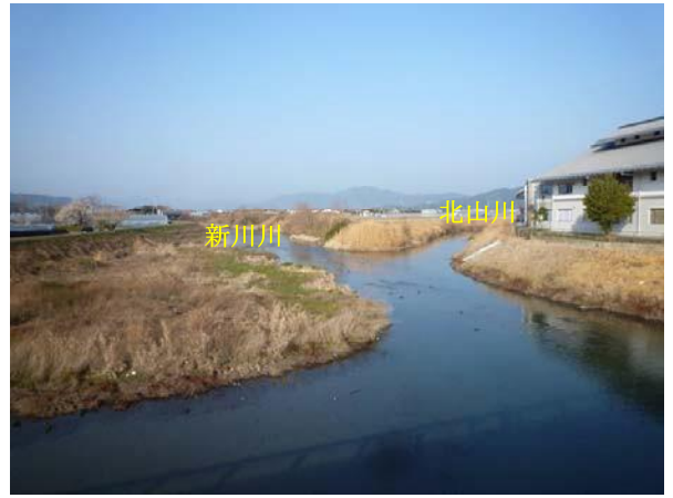
【写真7】新川川上流護岸（西分）
