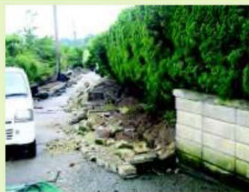
ブロック塀の倒壊による道路閉塞
