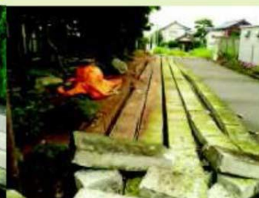
ブロック塀の倒壊による道路閉塞
