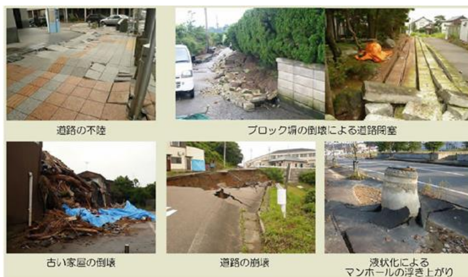
図7 揺れによって想定される被災状況
