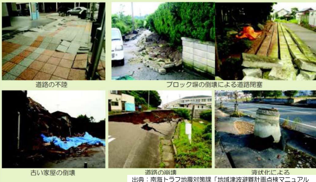
図 3-5 揺れによって想定される被災状
