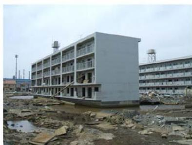
津波浸水後、地盤沈降により周辺が浸水
