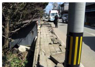
ブロック塀倒壊
