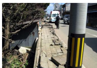
ブロック塀倒壊
