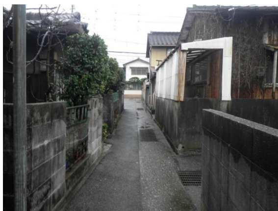
写真 5-2 建物とブロック塀の倒壊により津波避難経路が閉塞するおそれがある箇所の例
