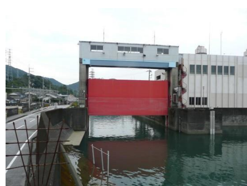
④孕橋より上流側の状況
