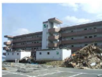
甚大な津波被害があった南三陸町で 町民の命を守った住宅
