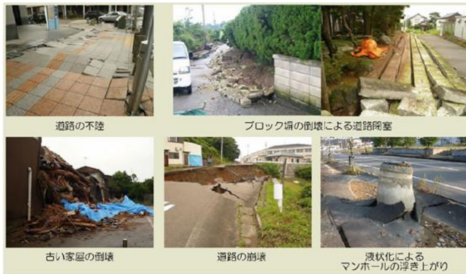
図8 揺れによって想定される被災状況
