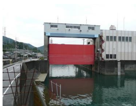
④孕橋より上流側の状況
