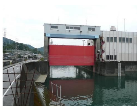
④孕橋より上流側の状況
