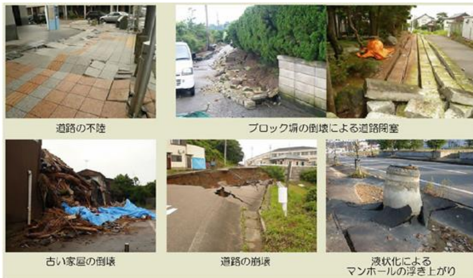
図 8 揺れによって想定される被災状況
