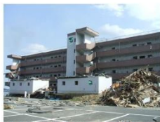
甚大な津波被害があった南三陸町で町民の命を守った住宅
