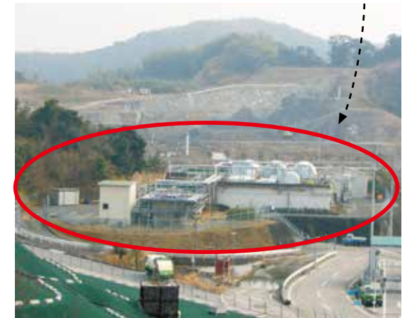
おすいしょりしせつ 污水处理施設
