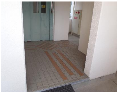
エレベーターホール
