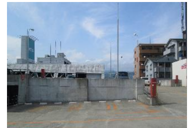
屋上スペース
