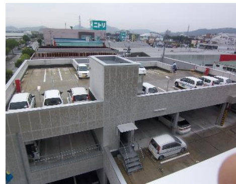
駐車場棟屋上
