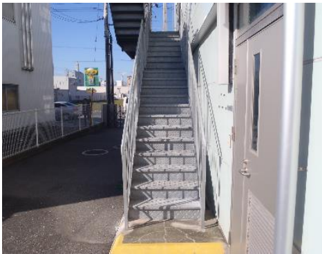
事務所棟外階段
