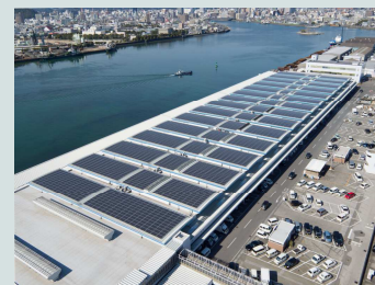
周辺に高層建物がなく日照条件のよい立地にあるため、太陽光発電事業を実施する民間事業者に卸売棟の屋根を貸し出している。
