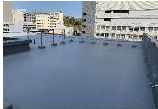
屋上津波避難スペース
