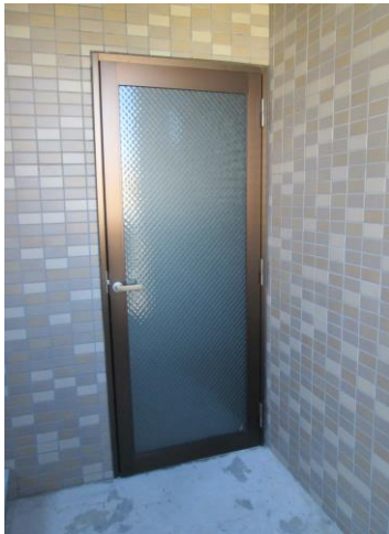
階段から廊下への入口
