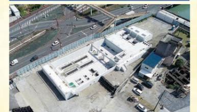
老朽化した下知ポンプ場の北側に、新たなポンプ場を建設中です。令和4年度は、令和2年度に着手した土木躯体の築造工事が完了しました。現在は、令和8年度の供用開始に向けて建築工事を進めています。新ポンプ場は、現施設の1.5倍の排水能力となるだけでなく、屋上に一時避難スペースを確保するなど、南海トラフ地震などの災害に備えた施設となります。
