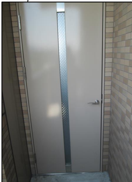
外階段から避難スペースへの入口
