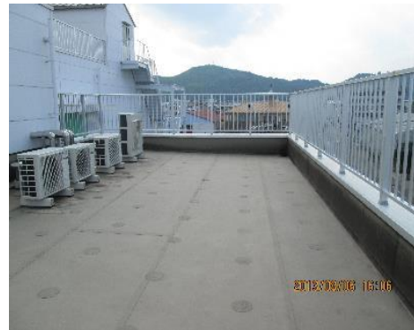
事務所棟屋上
