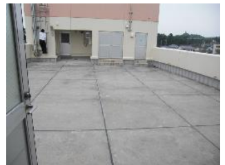
屋上避難スペース
