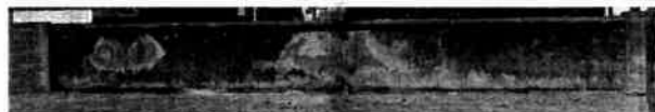
空襲の痕跡（熱によって赤茶けた部分）が残る土塀。写真は2018年に撮影されたもので、現在は周辺の開発により半分程度の長さしか残っていません。劣化も進んでおり、早急な対応が必要です。
