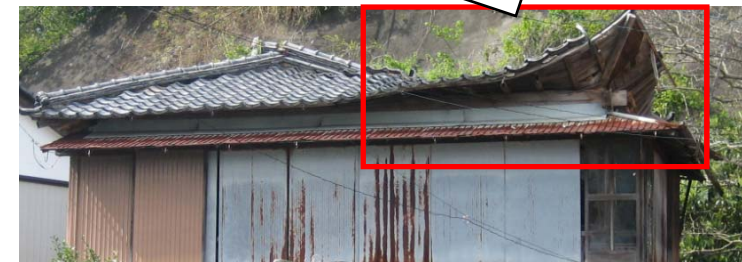
屋根の一部が陥没し 軒先が跳ね上がっている
