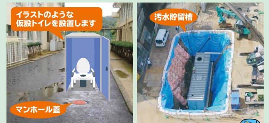
上下水道局では、令和4年度に泉野・小高坂小学校の2校にマンホールトイレを整備しました。災害時には、マンホールの上に仮設トイレを設置し、校庭に埋設した貯留槽へ汚水を貯留します。
