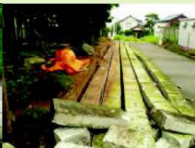
ブロック塀の倒壊による道路閉塞
