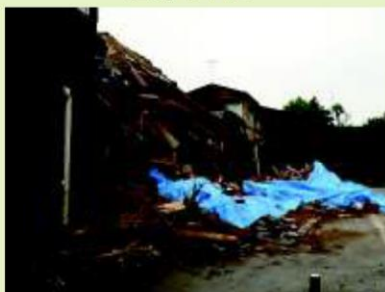
古い家屋の倒壊
