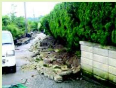
ブロック塀の倒壊による道路閉塞
