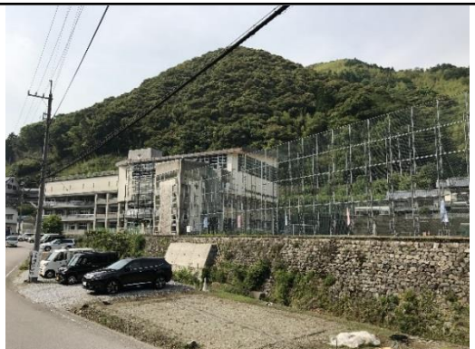
②土砂崩れなどの心配はないか（施設周 辺を確認）
