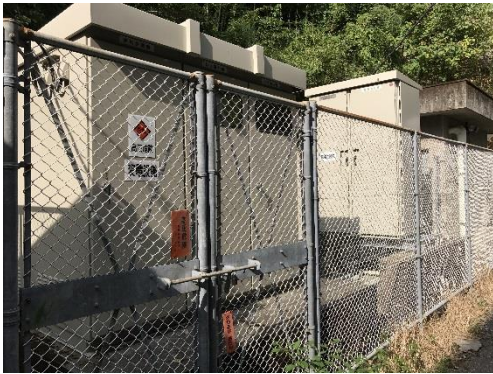
③変電設備：感電などの危険があるため 近づかない
