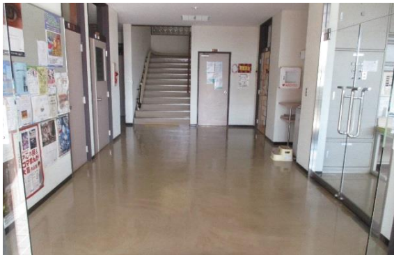
③天井：天井の落下はないか確認
