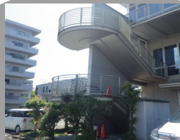
施設東側 一般避難者用 非常用階段
