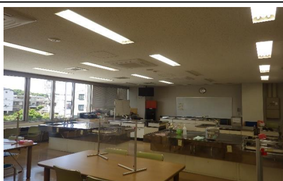
② 2階栄養実習室：照明などの落下はないか
