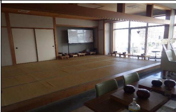
④ 3階娯楽室：天井の落下、窓ガラスの割れはないか
