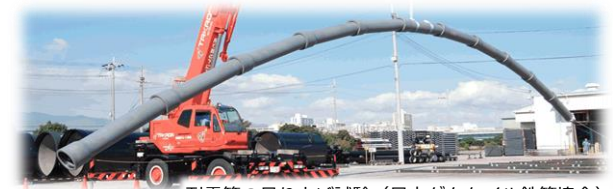
耐震管の吊り上げ試験 (日本ダクタイル鉄管協会)
