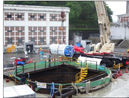
シールドマシン搬入状況（旭浄水場）
