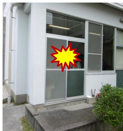
事務室南側入口
