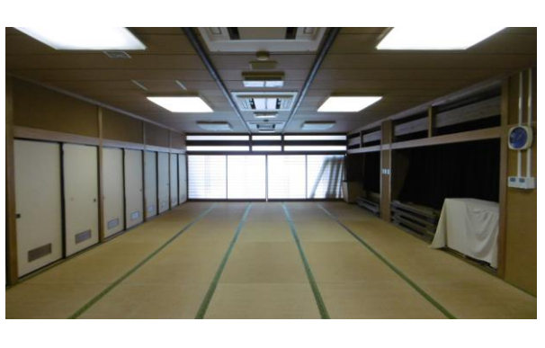
④各部屋：照明などの落下物はないか確認
