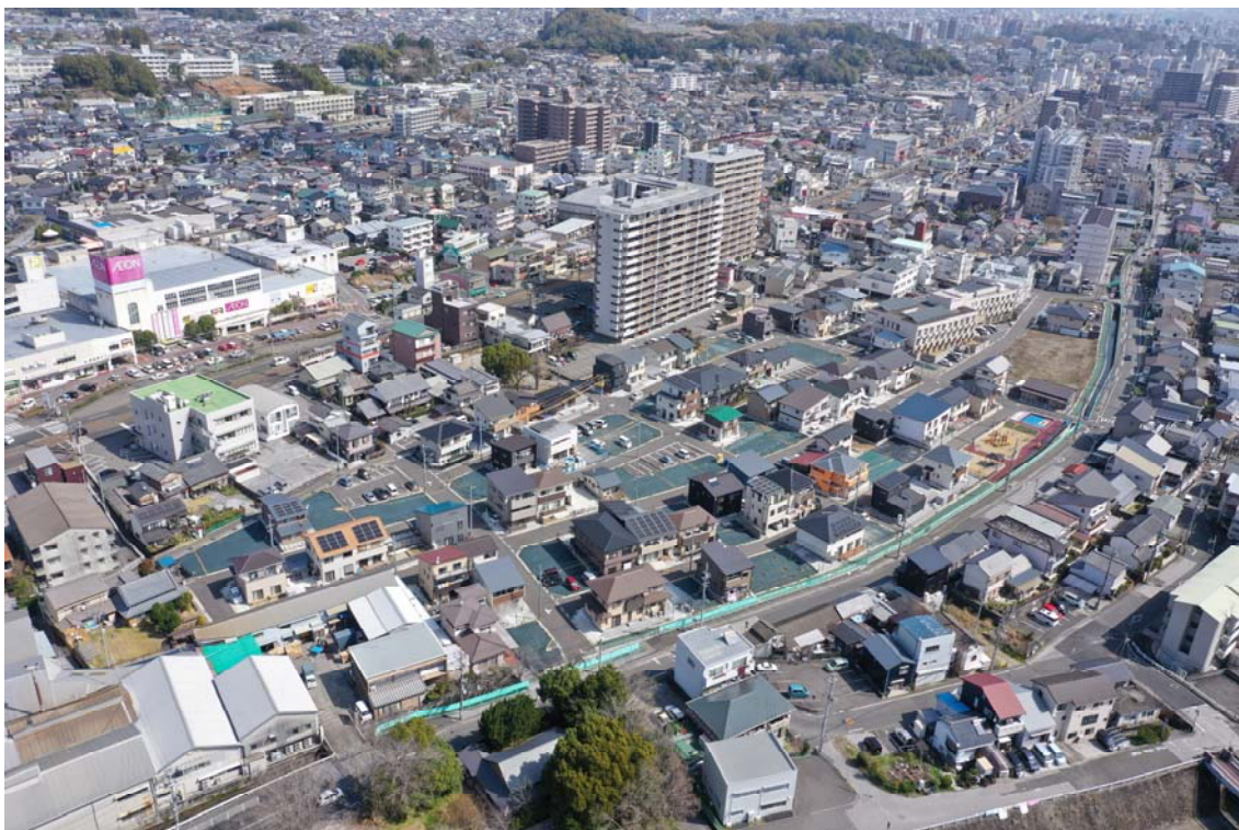
完成した下島土地区画整理事業の状況 (地区南西から北東を望む 令和3年3月)
