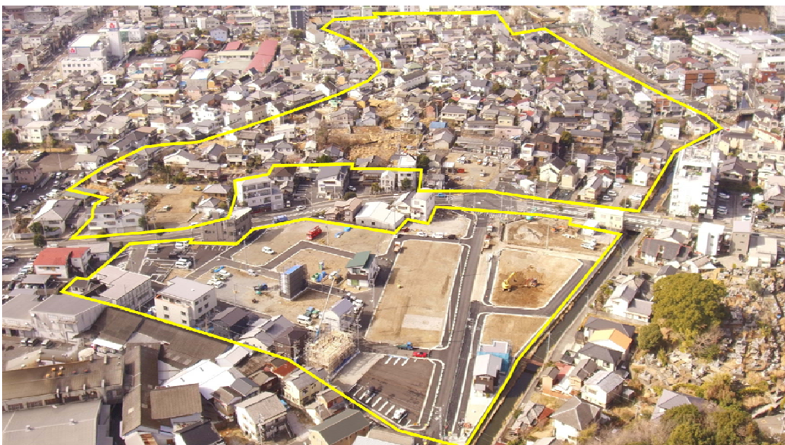
中須賀土地区画整理事業の状況 (地区東から西を望む 令和4年2月)
