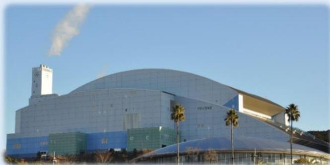
たりしているんだ。だから、煙突から出ている排ガスのほとんどが、水分なんだって。排ガスは、すごく高温だから、外気で急激に冷やされると真っ白く見えるんだ。冬の寒い朝に、息が白く見える現象と同じもの。ちなみに、煙突の出口付近が、透明に見えて、白い煙が離れて見えるのが水蒸気の特徴だよ。
