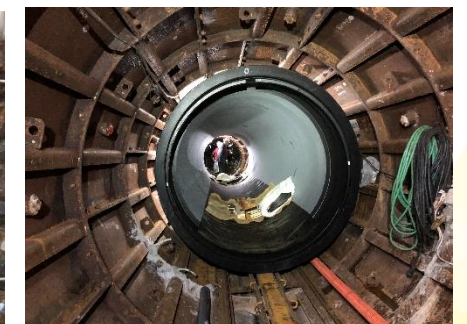
耐震管布設(二次覆工)
