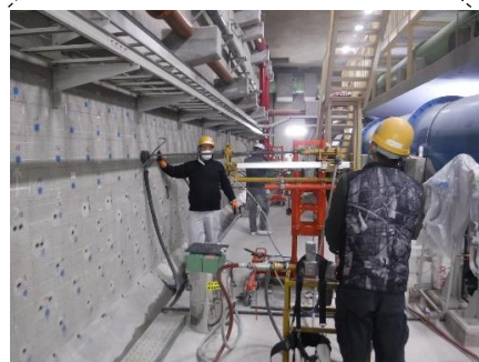
せん断補強筋による耐震補強(沈殿池)
