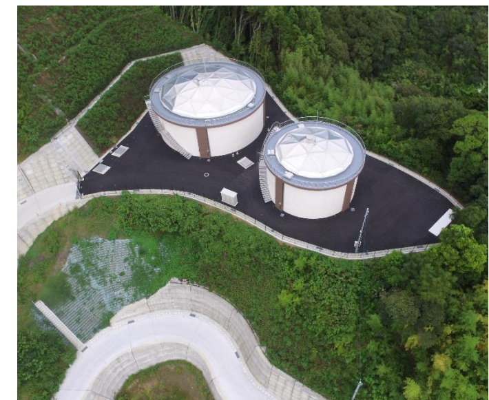
三里配水池外観
