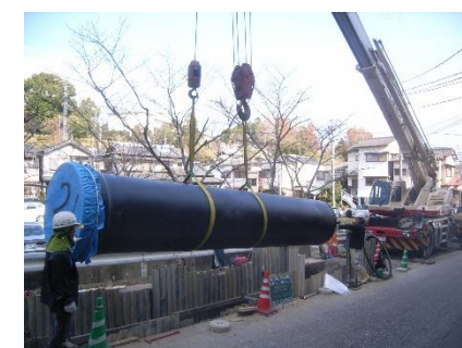
管吊り下ろし(開削工)
