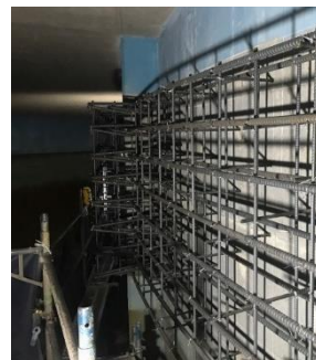
コンクリート増厚工法による耐震補強(配水池内部)
