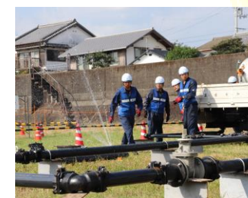
水道管復旧訓練 (高知市総合防災訓練)
