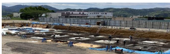
令和3年度施工状況
