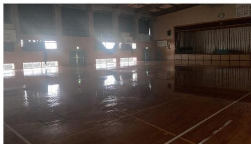
※屋内運動場の屋上防水の破損による雨漏りの影響で、床材や電気設備等について復旧が必要
