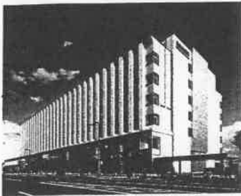
完成した北見市の新庁舎
