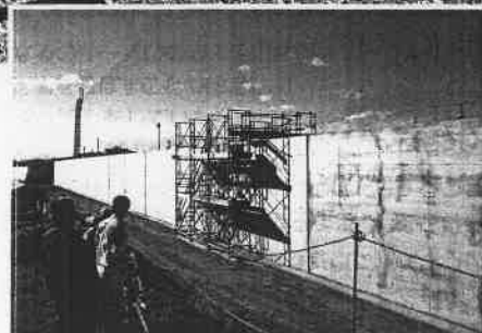
種崎地区の浦戸湾三重防護の防波堤現場
